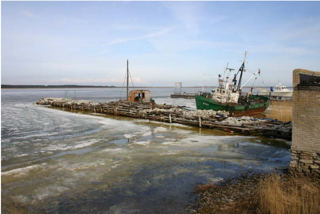
Foto 9. Kaid Bürgermeistri holmi kirdeosas on aastatega lagunenu. Asukoht vt joonisel 3 punkt 66. Foto A. Kask, 16.04.2006.a.
