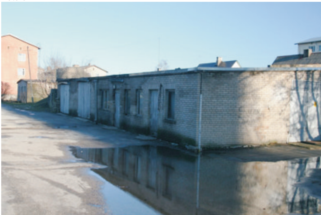
Gümnaasiumi majandushoone, taamal endine kooliteenija elamu. Majandushoone lõunapoolses otas asub elektri alajaam.
