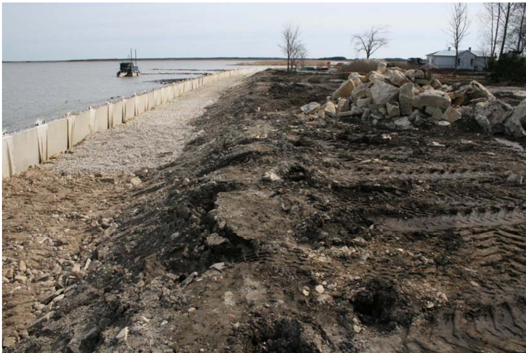
Foto 1. Alustatud on Haapsalu rannapromenaadi rekonstrueerimist.
